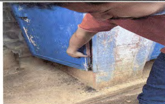
Foto 9: Bizagras de sanitario en mal estado.
